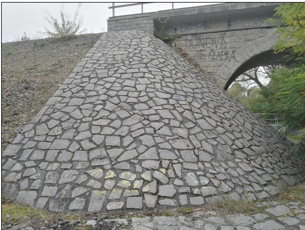
Obr. č. 7 - pohled zleva na zpevněný konec násypu u opěry Vejprnice
